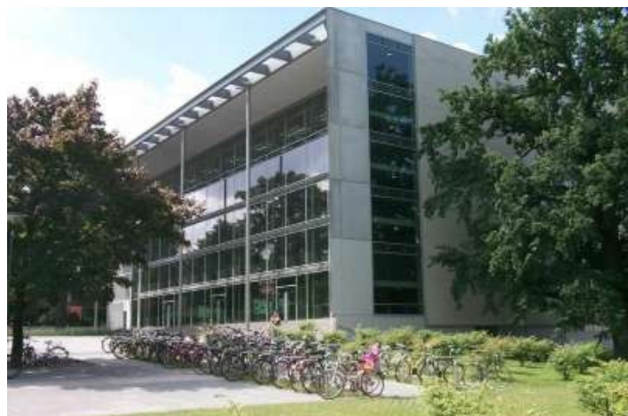
Hörsaalzentrum der TU Dresden direkt an der B 170, Richtung Prag
